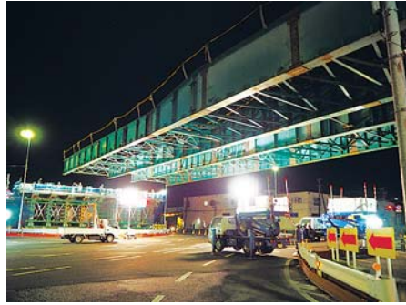
国道4号に交差する市道の上空に約85tを送り出した
